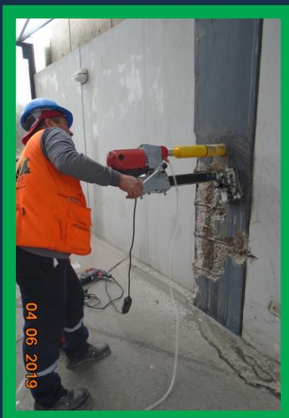
Extracción de testigos de concreto con brocas diamantinas
